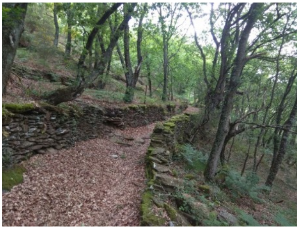
Muros antigos presentes no ENIL
