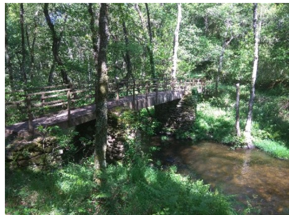
Ponte sobre o río Loio
